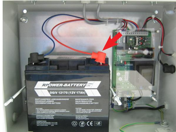
Batterie einbauen und die Anschlusskabel (rot und blau) polrichtig an die Batteriepole (rot + / blau -) anschließen.
