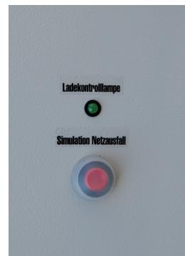
Die Ladekontrollleuchte an der rechten Seite signalisiert Ladung. Die Betätigung des Prüftasters löst einen Test aus, wobei bei gedrücktem Taster die Ladekontrollanzeige erlöschen muss.
